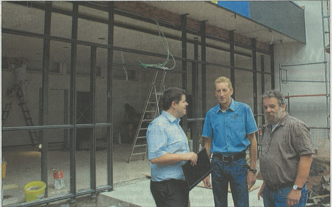
Vor-Ort-Termin in der Durbacher Staufenberg-Schule, die fleißig saniert wird, (von links): Bürgermeister Andreas König, Schulleiter Heinz Baumann und Bauleiter Rolf Dörr.
